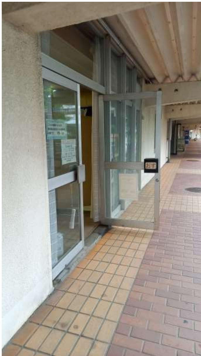
入口 (トイレ側から撮影)
